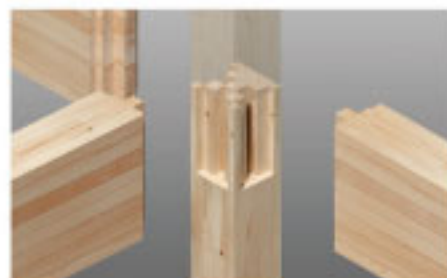
一般的な在来工法の接合部
